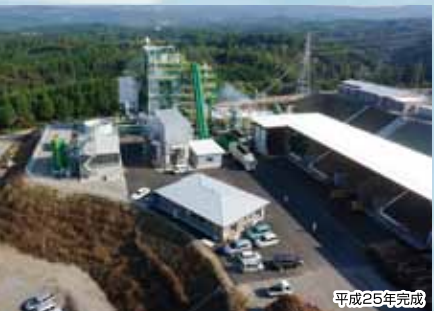
天瀬発電所新築工事
