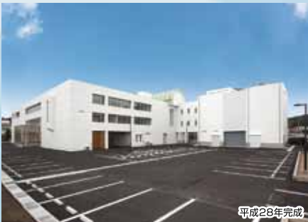
日田市複合文化施設(アオーゼ)増改築工事 (鉄骨造・鉄筋コンクリート造/4358㎡)
