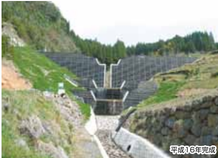
砂防工事 落水砂防ダム工事
