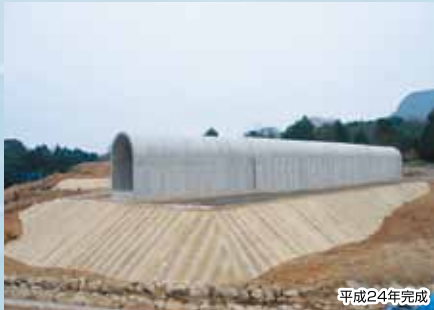
三光本耶馬溪道路函渠設置工事
