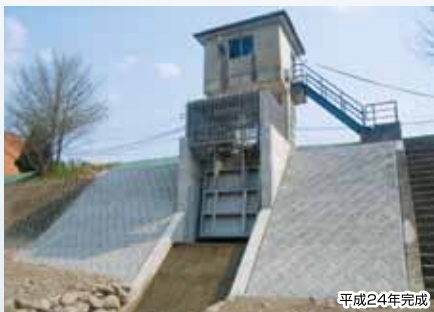
筑後川中大山樋管工事
