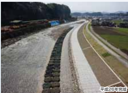
花月川三和地区掘削護岸災害復旧工事
