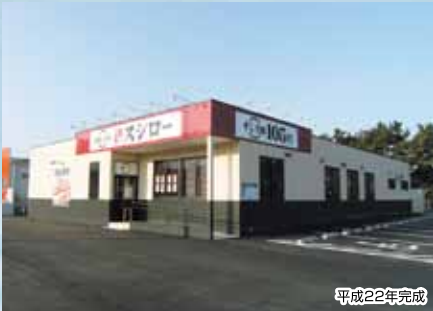
スシロー八幡黒崎店新築工事(木造/334㎡)
