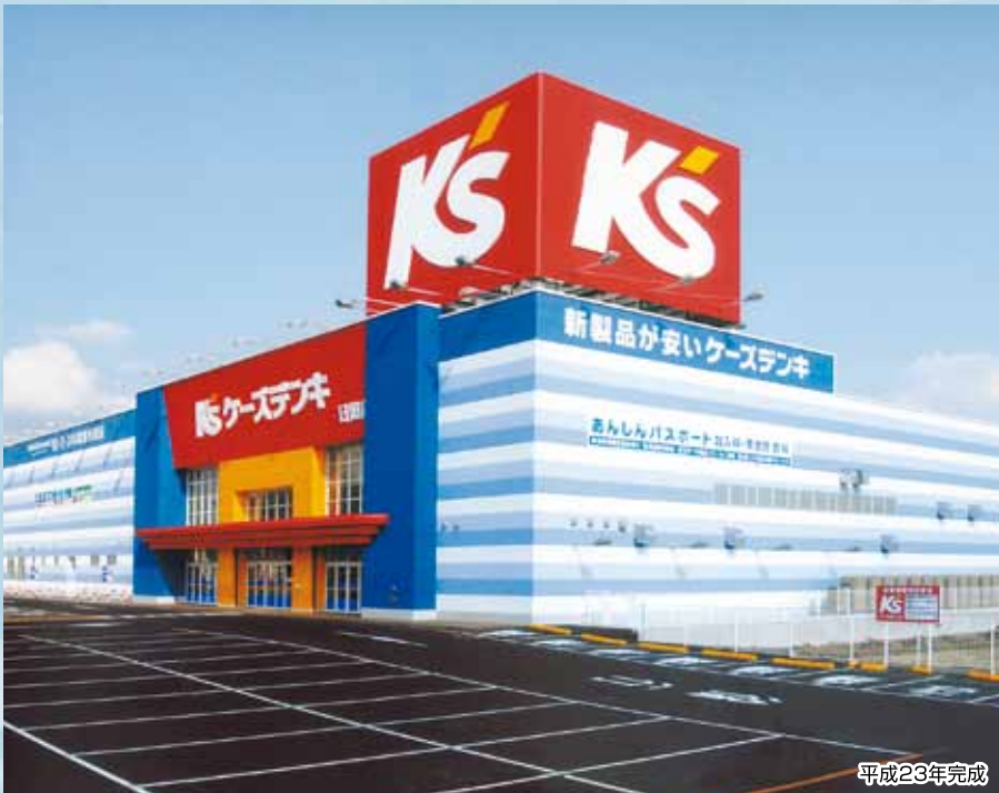
ケース電気日田店新築工事(鉄骨造/3937㎡)
