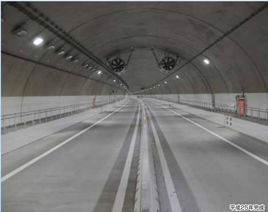
東九州道(蒲江～県境)葛原トンネル北工区舗装工事 (国土交通省 九州地方整備局長 表彰)
