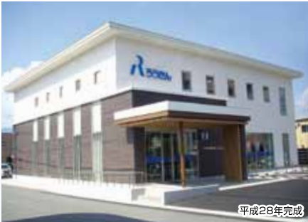
九州労働金庫(鉄骨一部鉄筋コンクリート造/696㎡)
