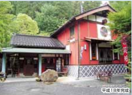
琴平ギャラリー棟新築工事(木造/105㎡)
