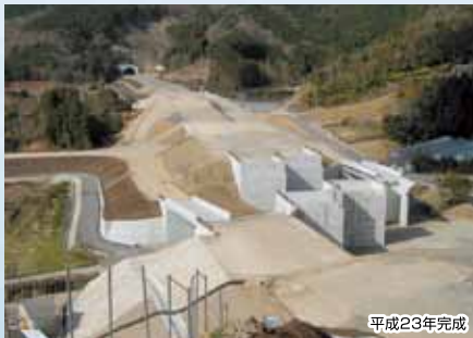
東九州道(蒲江～県境)森崎地区第3工区改良工事 (国土交通省 佐伯河川国道事務所長 表彰)
