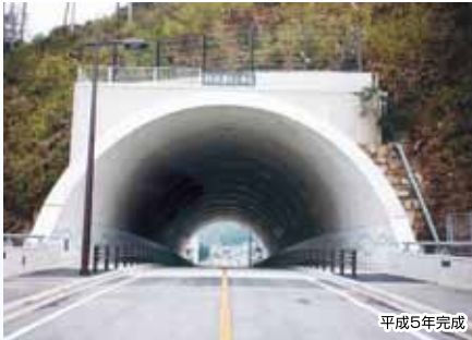
トンネル工事 比佐津トンネル工事
